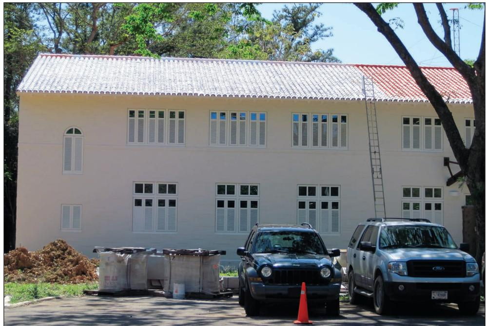
Figura 11—Restauración de las tejas del Edificio del Instituto. Noten las nuevas ventanas.
