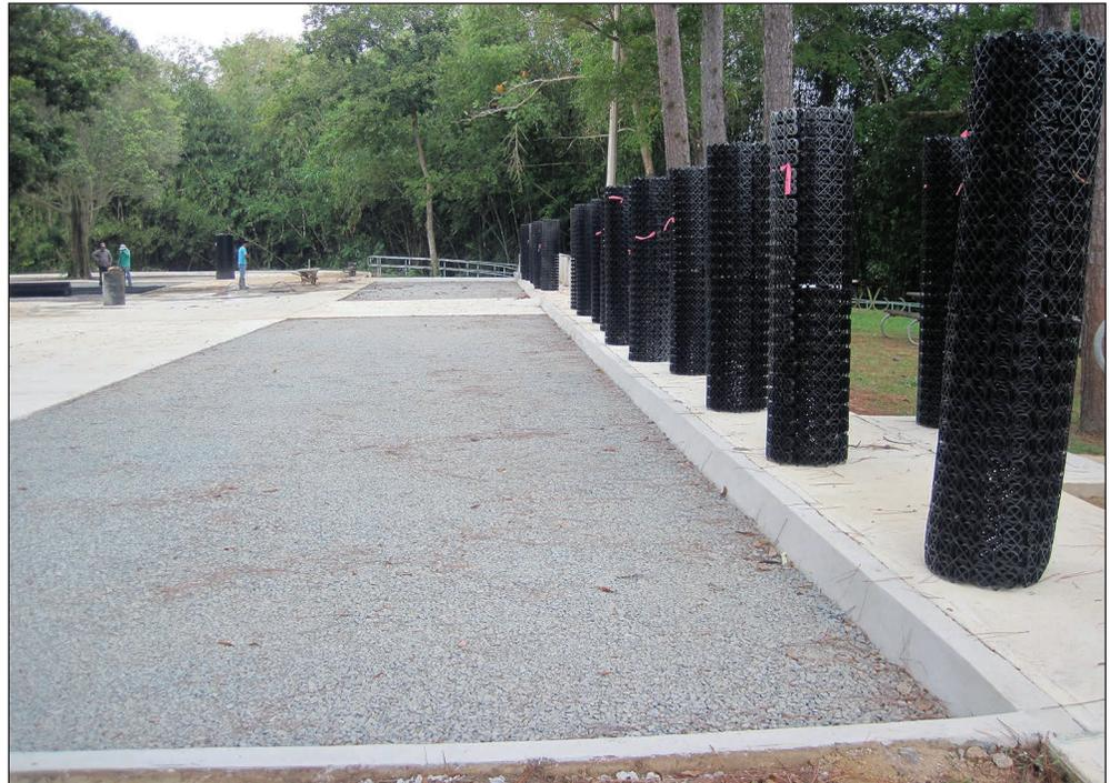
Figura 33—El Estacionamiento Verde tiene varias capas de material. Los anillos plásticos negros, vistos en la acera, se añadieron a estas capas para reforzar el sistema.
