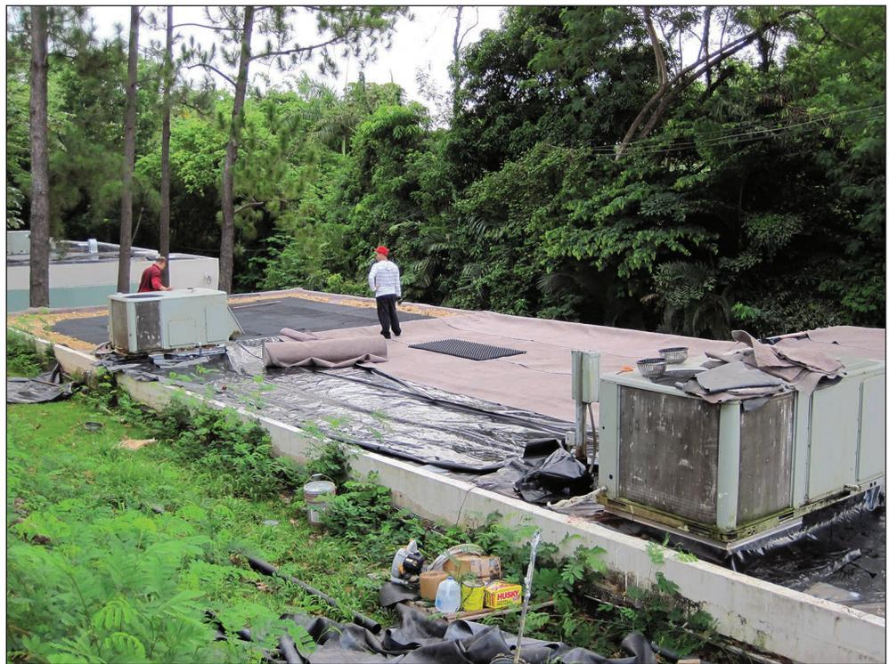
Figura 19—Disposición de materiales sobre los techos frescos como preparación para el techo verde del laboratorio de Sistema de Información Geográfica y de Percepción Remota.
