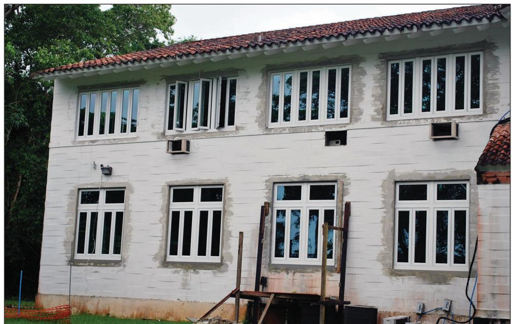
Figura 27—Montaje de las ventanas en el Edificio del Instituto.
