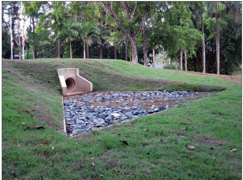
Figura 22—Salida para el sistema hidrológico del Estacionamiento Verde. Las piedras disipan la energía de las aguas salientes antes de que fluyan hacia abajo por el césped, que sirve de hondonada verde que absorbe y evapora el agua.
