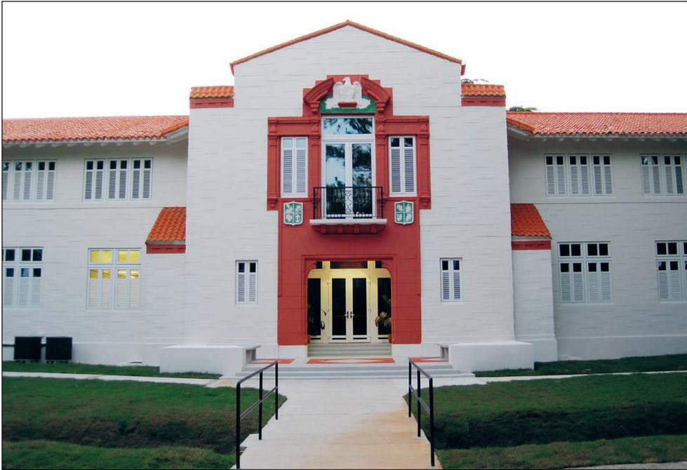
Figura 30—Fachada principal del Edificio del Instituto terminada. Los pasamanos señalan el paso de los canales de desagüe que originan en el Estacionamiento Verde.
