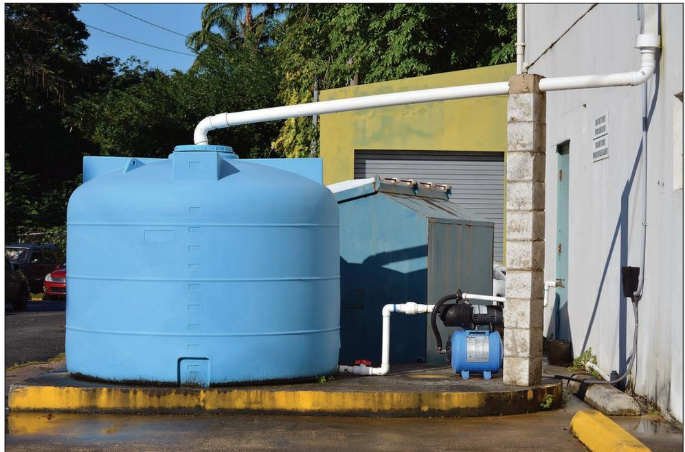
Figura 20—El sistema de recolección pluvial del techo ubicado de la biblioteca Frank H. Wadsworth. La foto exhibe la tubería de desagüe desde el techo a la cisterna azul, la bomba que devuelve el agua hacia el techo durante sequías y la cisterna azul donde se almacena el agua.
