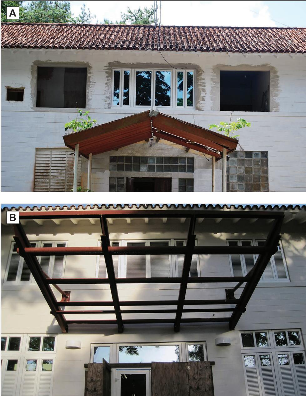
Figura 32—El Edificio del Instituto tenía una entrada al oeste con vista al estacionamiento (a) que no era parte del diseño original del edificio. Mantuvimos la función de esta entrada con la instalación de una estructura nueva (b) que no ha sido pintada como lo pedía el diseño debido a limitaciones presupuestarias.
