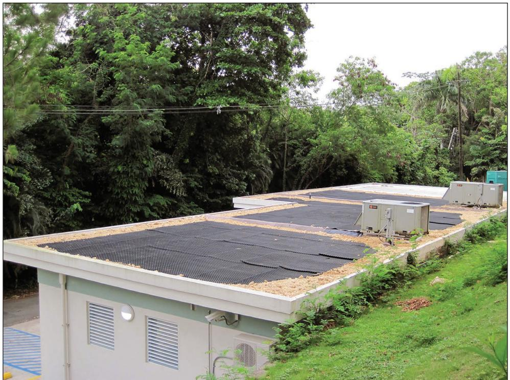
Figura 13—Preparación del techo verde para sembrar el material de vegetación verde para el laboratorio de Sistema de Información Geográfica y de Percepción Remota.
