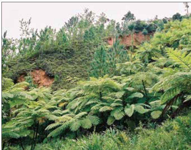
Este gran desprendimiento a 600 m de altura (es decir, en el kilómetro 21 sobre la ruta PR 191) se produjo después de fuertes lluvias en 1970 y cerró permanentemente la autopista. ARRIBA: el desprendimiento con poca vegetación en 1981. ABAJO: la misma área con una cubierta más densa en 2005. Nótese la abundancia del Cyathea arborea nativo (helecho arborescente) y la presencia del Pinus caribaea (pino macho) introducido. (Fotografías de Peter L. Weaver)
